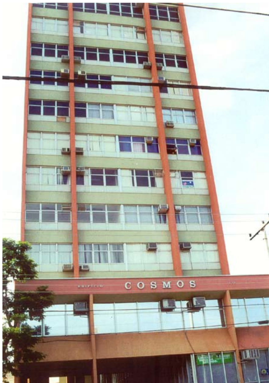
Edifício Cosmos, em Campo Grande (MS) - uma das primeiras sedes do Tribunal de Justiça de MS
